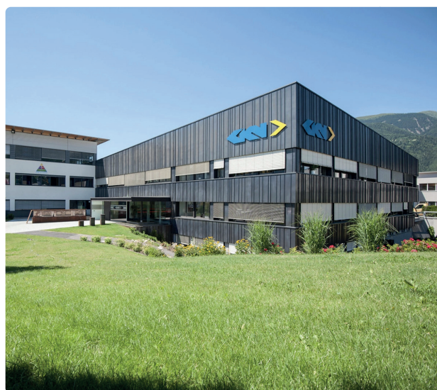
GKN Powder Metallurgy, sede centrale, Brunico, Alto Adige
